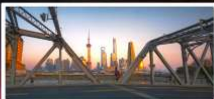
สะพานไวปี้ดู่
